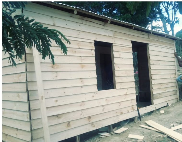
Modelo de Vivienda construida por la Fundación Sueños Realizados (FUSURE) a favor de madres solteras.
